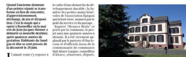
Datant de 1885, la maison du peintre Jean-Jacques Henner était très abîmée et a nécessité d'importants travaux de réhabilitation. Elle est désormais devenue un espace central de vie et d'échange pour les villageois. Photo: V. Voeglin
